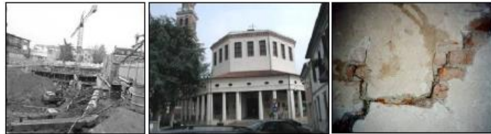
1995: scavi per la costruzione di un parcheggio sotterraneo Chiesa della Rotonda e altri monumenti danneggiati
