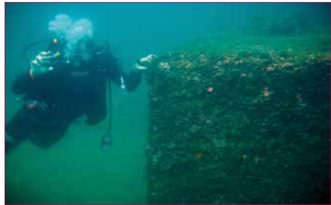
Fig.6 - Particolare delle Pilae.
