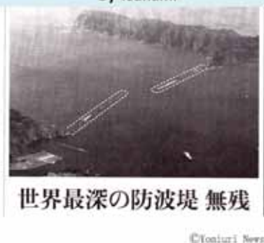
Figura 4b - Le grandi barriere marine distrutte dallo tsunami a Kamaishi Bay.
