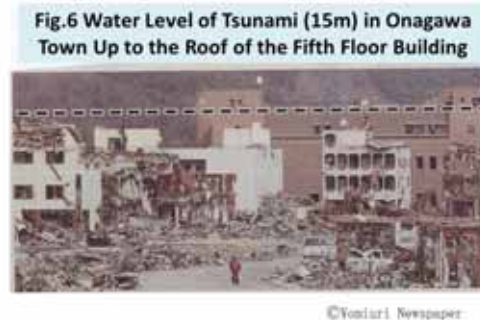
Figura 6 - Livello dell'acqua raggiunto (15 m) a Onogawa fino al 5 piano dell'edificio
