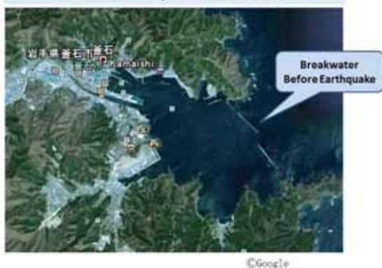
Figura 4a - Le grandi barriere marine contro gli tsunami a Kamaishi Bay. Prima del terremoto.
