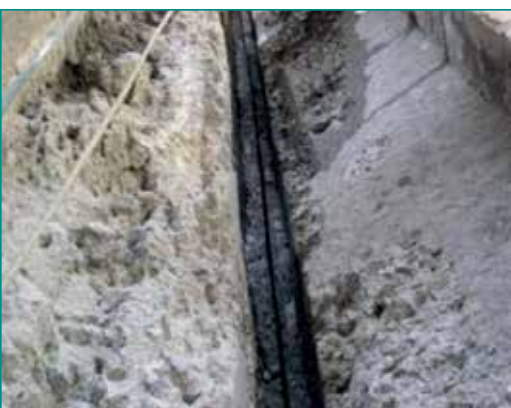
Fig. 8 - Diga Poggia (EDISON - BS) : taglio di nuovo giunto strutturale 2005. - Fig. 9 - Diga Pian Sapeio (TIRRENO POWER - GE): riprofilatura sfioratori. 2011- Fig. 10 - Diga Beaugard (CVA - AO): parziale demolizione 2013-2015.
