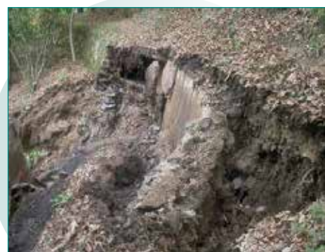
Fig. 11 - Cedimento di un canale.
