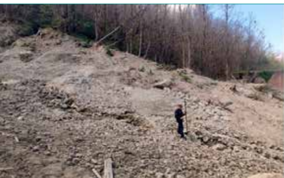
Acquisizione dei dati di appoggio alla fotogrammetria relativi al territorio di Ischia
