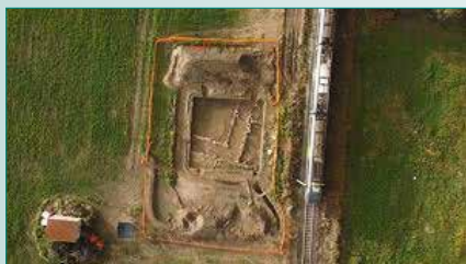
Fig. 1 - Linea Palermo- Catania. Lotto 3. I lavori a Valledlunga Pratameno.
