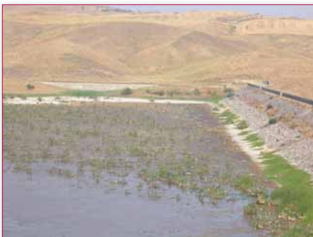
Figura 2 – Interrimento di un bacino artificiale nei pressi di Gela (Sicilia). Particolare dei sedimenti affioranti a ridosso della diga.
