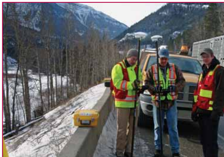
Il team di rilevamento del BCMoT – Geoff Methuen, Rod Ralston e Luke Dickieson – imposta i punti di controllo per il progetto usando ricevitori GNSS Trimble R8.
