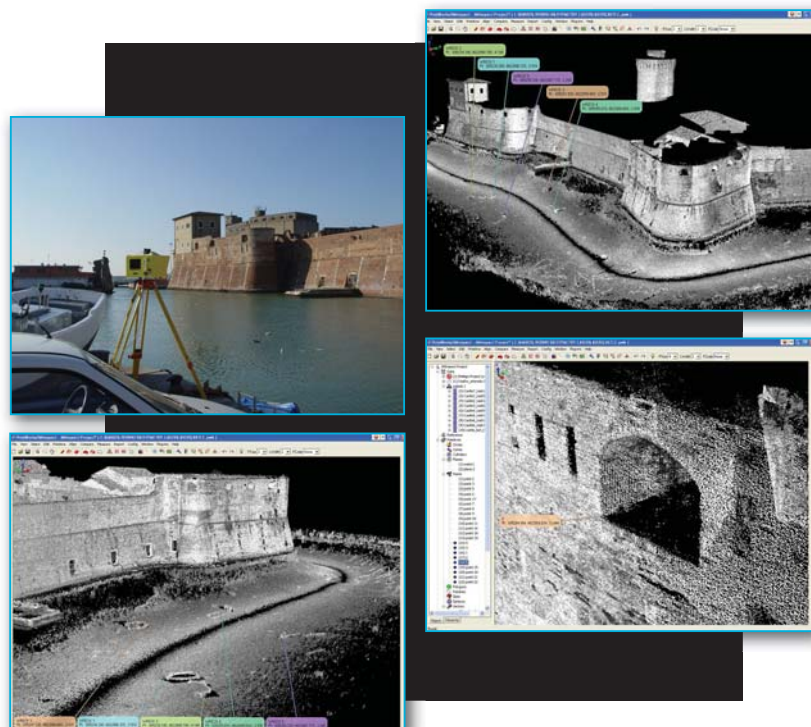
Figura 3, 4, 5 e 6 (in senso orario) - Fortezza Vecchia nel porto di Livorno - viste 3D del rilievo integrato sopra e sotto il pelo dell'acqua - I relitti sul fondale sono ben evidenziati dall'immagine side scan - una crepa in evidenza.
