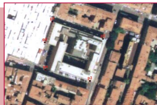
Per giudicare – almeno visivamente – i risultati del lavoro si può sovrapporre il layer del DEM, in scala cromatica, su strati del modello posizionati per altra via (cartografia vettoriale, ortofoto, un altro DEM qualitativamente migliore). Gli scostamenti sono in genere impietosamente evidenziati.
