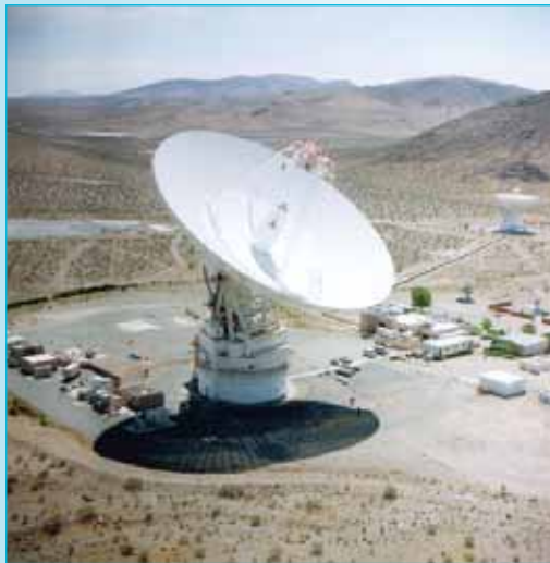
Una delle antenne da 70 metri di diametro della Deep Space Network della NASA. I centri DSN sono situati a Goldstone, California (in figura), Madrid, Spagna e Canberra, Australia. La disposizione sul globo terrestre garantisce una copertura costante delle missioni in atto, indipendentemente dalla rotazione terrestre.
