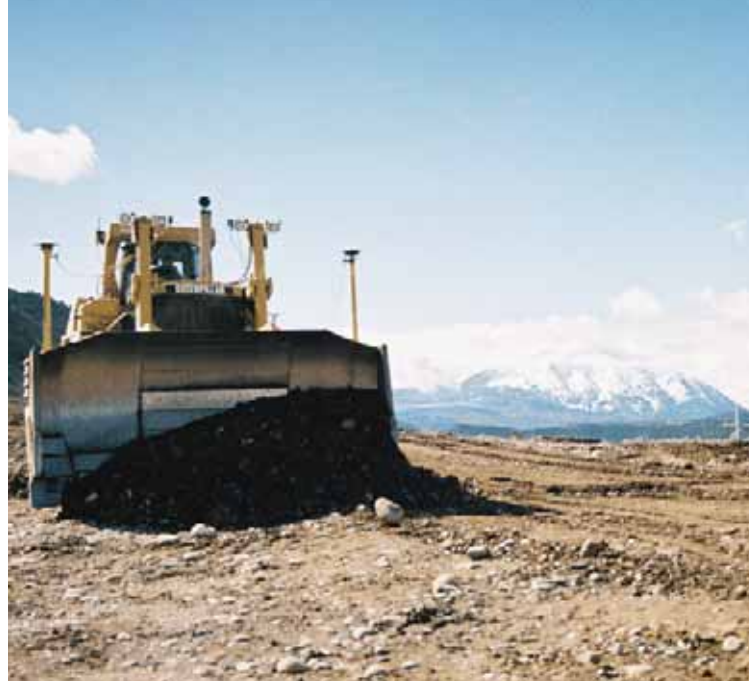
Fig.4 - Scavi e sbancamenti possono essere gestiti in maniera quasi automatica, semplicemente passando al dozer il modello digitale del terreno definito in progetto.
