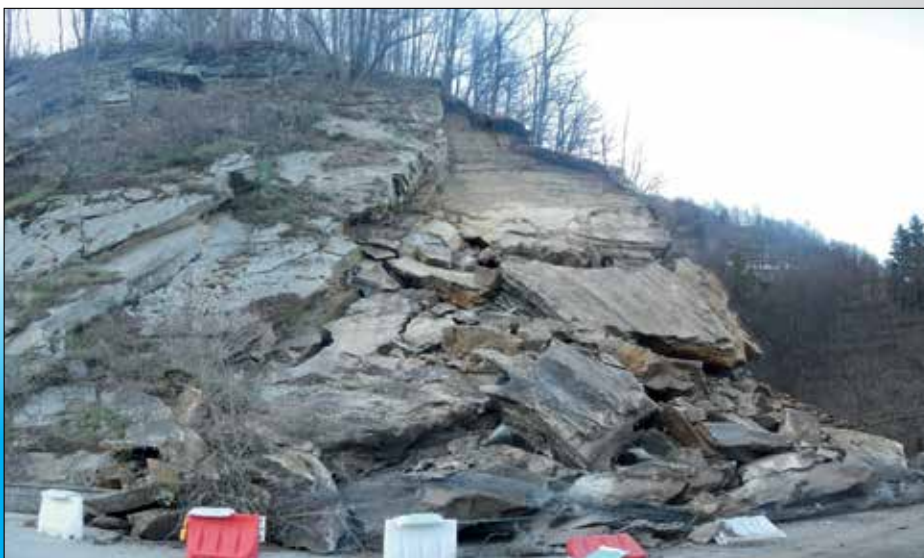
Fig. 3 – La stessa area fotografata immediatamente dopo il crollo.
