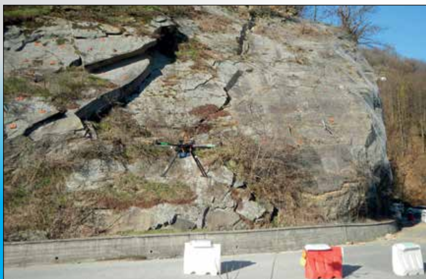
Fig. 1 – Fasi di rilevamento dell'ammasso roccioso prima del crollo, sullo sfondo la profonda frattura che caratterizzava la parete rocciosa e che rappresentava la principale evidenza della crescente instabilità.
