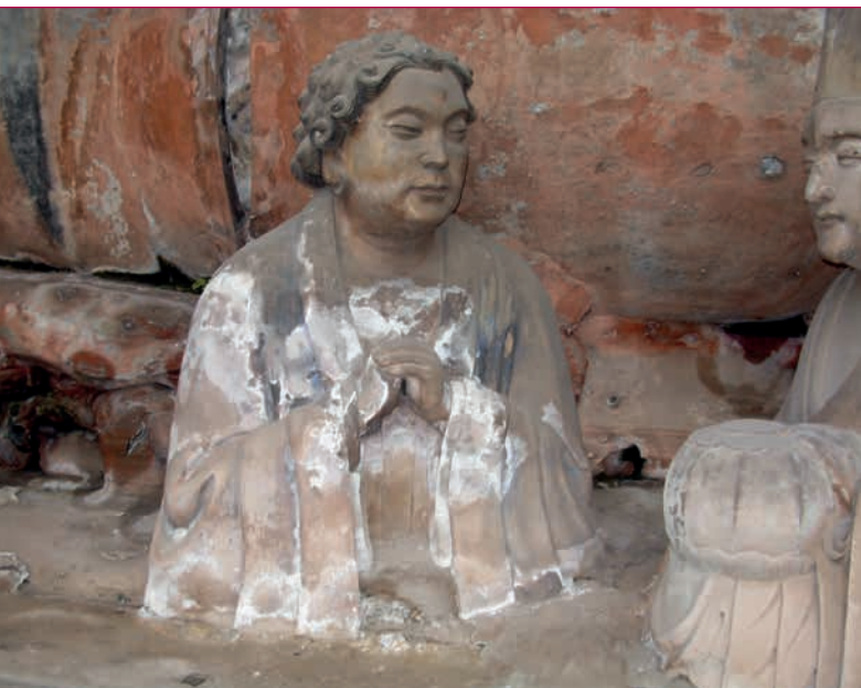
Fig. 6 - Formazione di efflorescenze.
