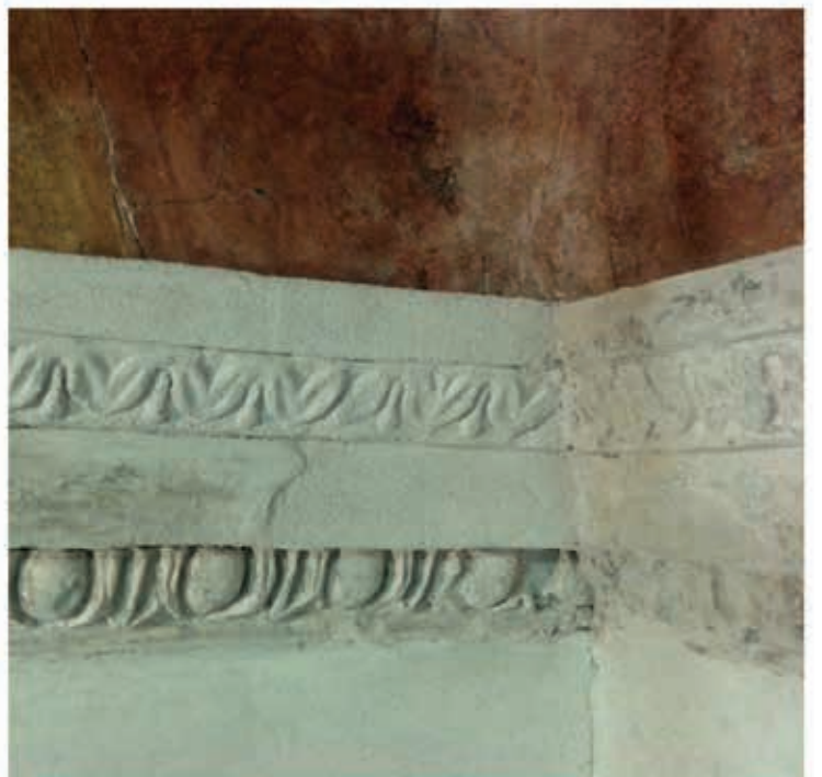
Fig. 5 - Risultato dell'applicazione di un positivo realizzato in stampa 3D all'interno di una delle lacune; a destra come appare la cornice dopo la velatura a acquerello.
