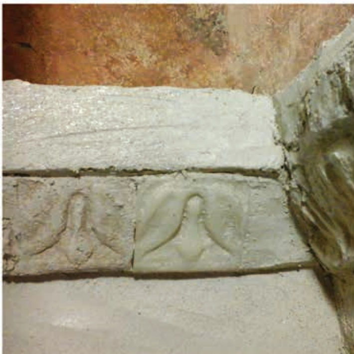
Fig. 5 - Risultato dell'applicazione di un positivo realizzato in stampa 3D all'interno di una delle lacune; a destra come appare la cornice dopo la velatura a acquerello.
