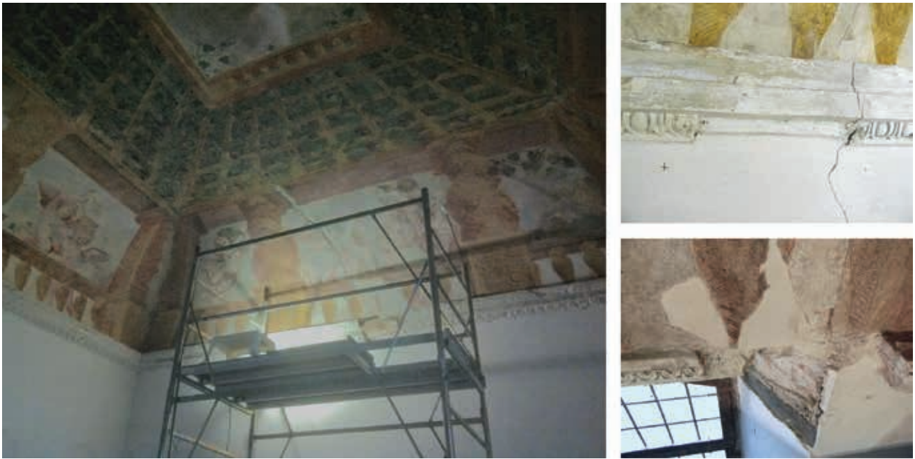
Fig. 1 - La Sala di Cristoforo Sorte con alcuni particolari delle lacune presenti nella cornice.
