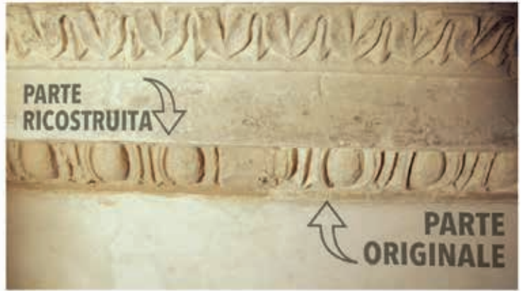
Fig. 4 - Fasi di lavoro dell'integrazione della lacuna con l'utilizzo a stampo della riproduzione in stampa 3D del negativo .
