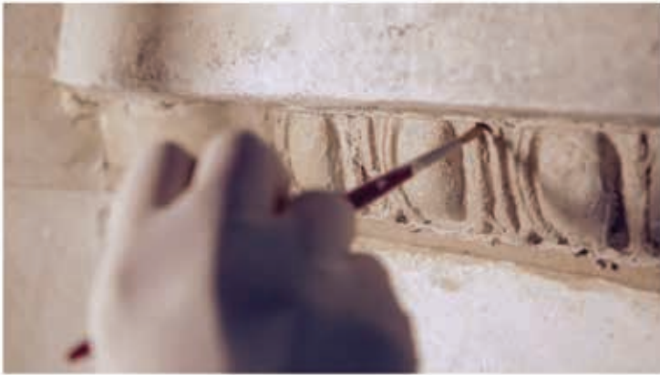
Fig. 4 - Fasi di lavoro dell'integrazione della lacuna con l'utilizzo a stampo della riproduzione in stampa 3D del negativo .
