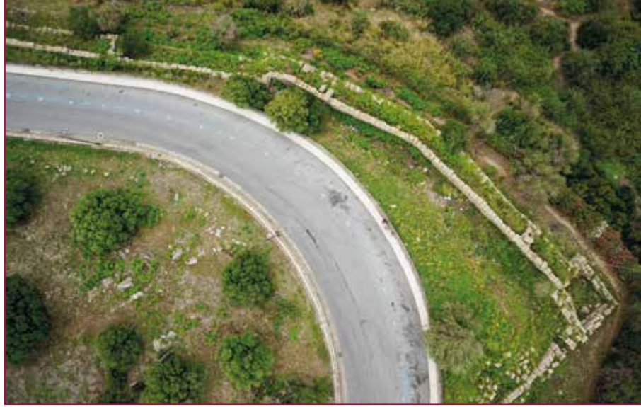
Fig. 2 - Porzione delle mura del sito viste dall'alto.
