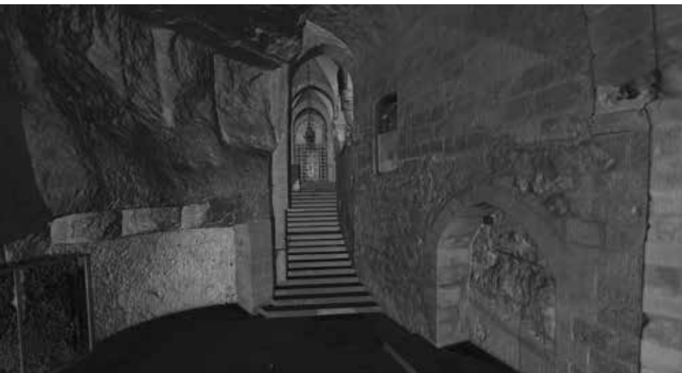
Fig. 4 - Mesh 3D delle scale che conducono alla Cappella dell'Invenzione della Croce. L'elevato livello dettaglio consente di leggere le differenti tessiture murarie e le lavorazioni superficiali. (Elaborazioni della mesh Lidia Fiorini)
