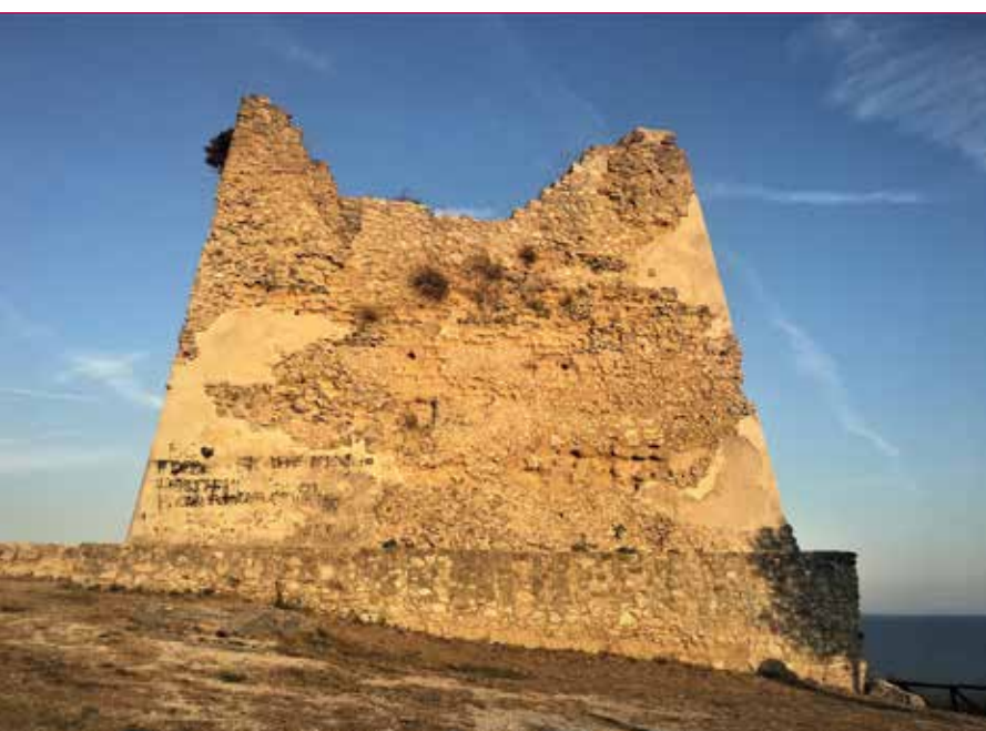
Fig. 1. Scauri (LT), Torre del Monte di Scauri, fronte sud-ovest.
