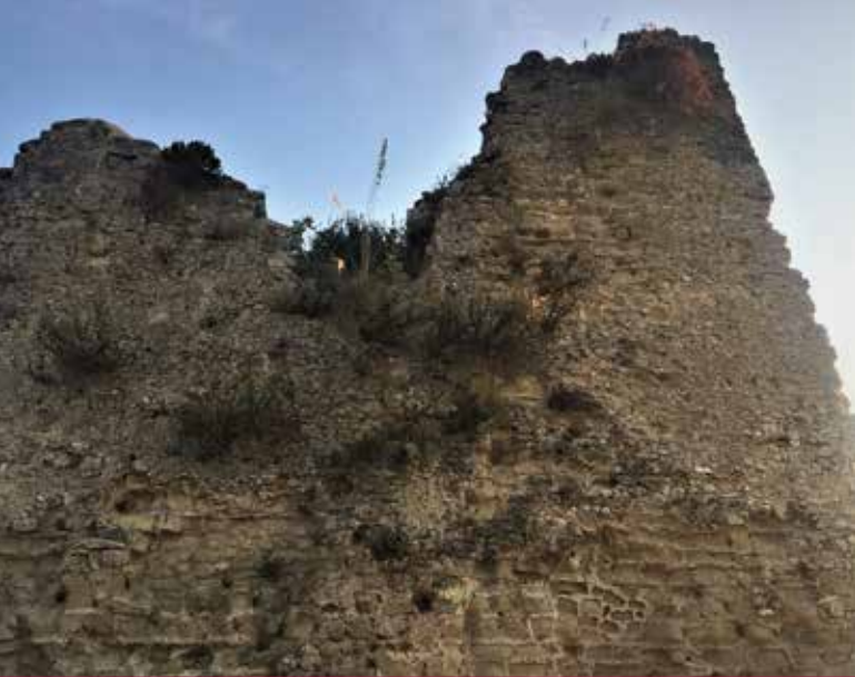
Fig. 4. Scauri (LT), Torre del Monte di Scauri, fronte nord-est, particolare della porzione sommitale.
