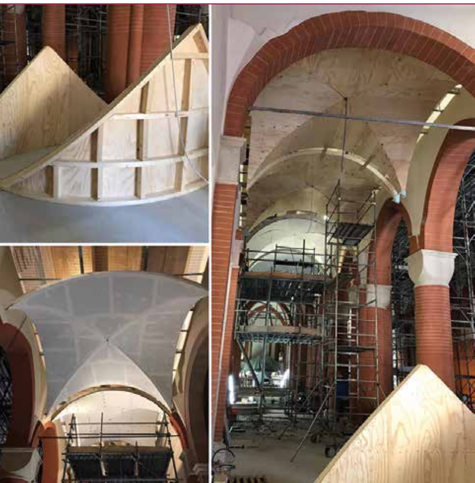
Fig. 4 - Messa in opera delle volte leggere.
