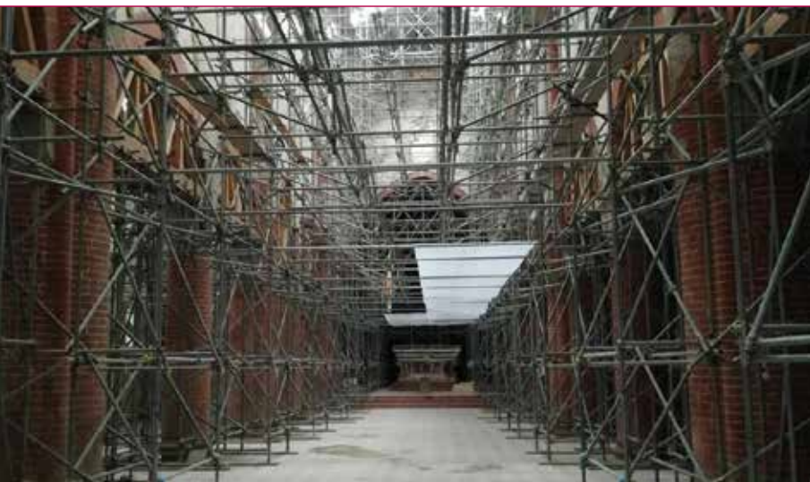
Fig. 1 - Lavori di messa in sicurezza dopo i crolli.
