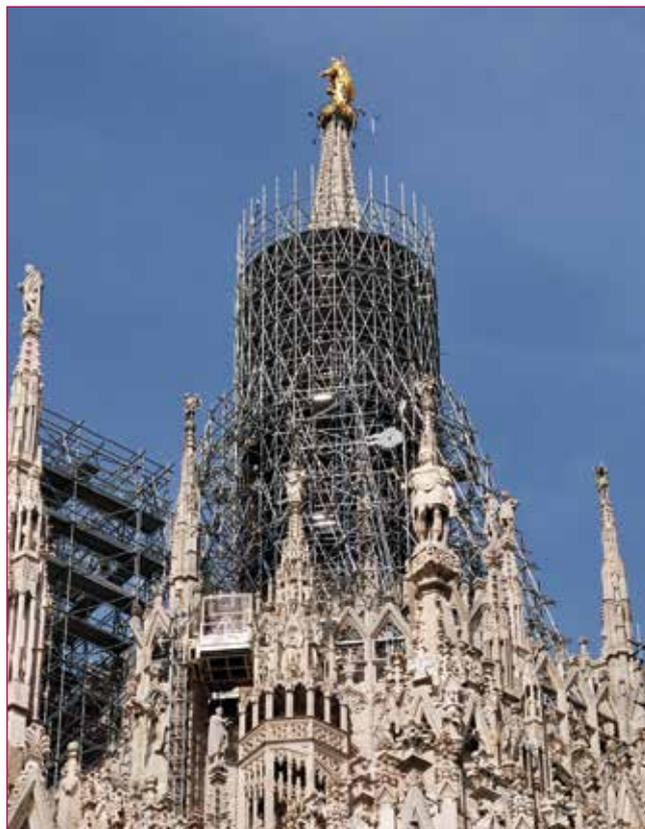
Fig. 1 - Ponteggio parzialmente completato.
