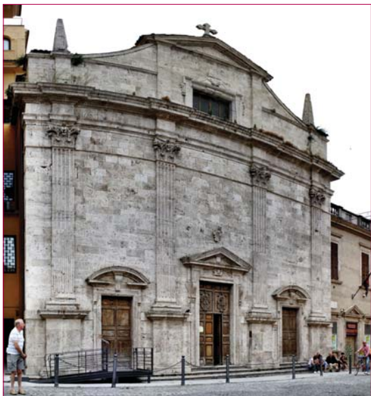
Chiesa di S. Maria della Carità (AP) - Uno dei panorami della facciata, la curvatura visibile si deve alla proiezione sferica.
