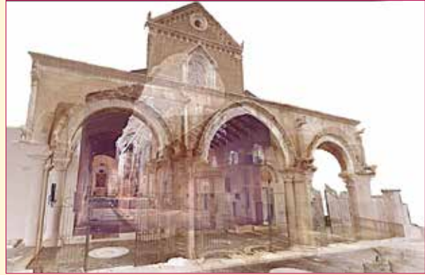
Fig. 1 - La cattedrale di Sessa Aurunca: sovrapposizione delle nuvole di punti esterne ed interne.
